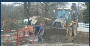
Travaux des séparatifs des eaux pluviales et usées, réalisés en février 2020, impasse de la Mairie, pour alléger la charge de la station d'épuration. Ceux-ci ont été effectués par l'entreprise Barou.
